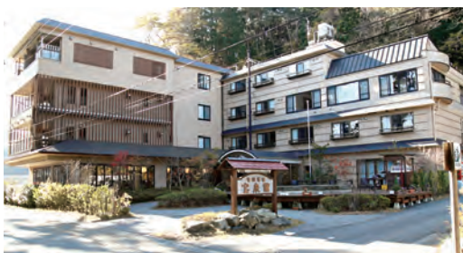
①宝来館本館はコンクリート4階建て。津波で2階部分までが浸水したが倒壊は免れた
