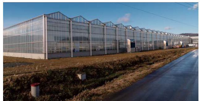
広大な敷地に建つトマト(1.1ha)とパプリカ(1.3ha)のフェンロー温室
