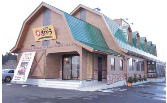
「まるぎゅう」の外観
