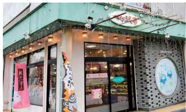
沢菊本店は店舗営業こそしているが、裏にある蔵や工場などは全面的な復旧には至っていない
