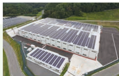
左／住宅用鋼製建材や太陽光発電システムの架台を製造する機械。上／工場の屋根や敷地内に設置された太陽光発電モジュールで、工場の稼働に必要な電力の全てを賄っている。
