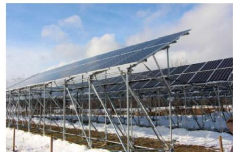
30度の急傾斜で地面から2.5メートルの高さに設置された太陽光パネル
