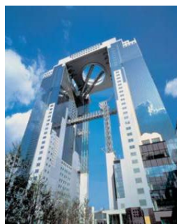
地上40階・地下2階建ての 「梅田スカイビル」
