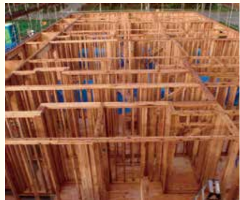
(写真は、気仙杉を用いた集合住宅の建設)
