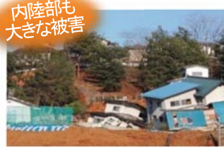
家屋被害の状況（福島市伏拝地内）
