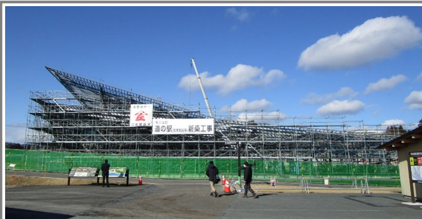
工事が進む道の駅「さんさん南三陸」の駅舎
