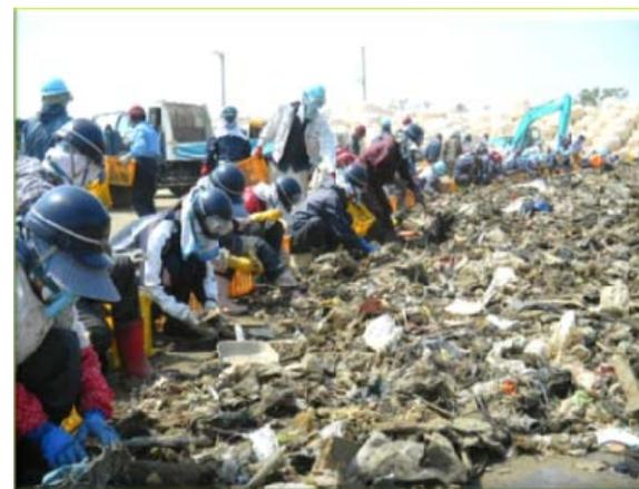
③徹底した手作業により19品目に分別し最終処理
