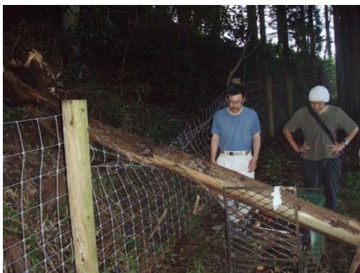
倒木により破損した金網柵
