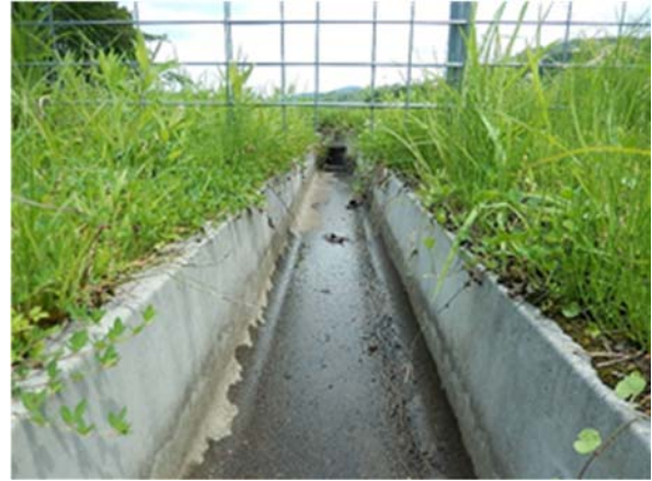
侵入口となりやすい側溝
