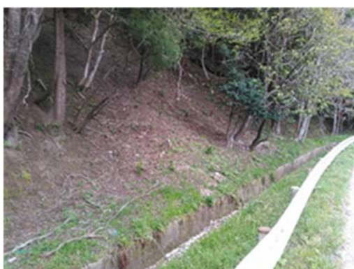
道路周辺の緩衝帯の整備
