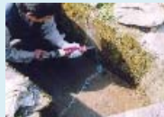
水路のひび割れ補修
