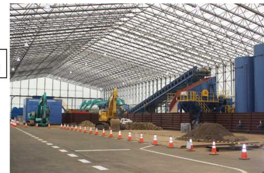
受入・分別施設(大熊1期②工区)
