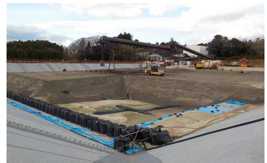
土壌貯蔵施設(双葉1期①工区)
