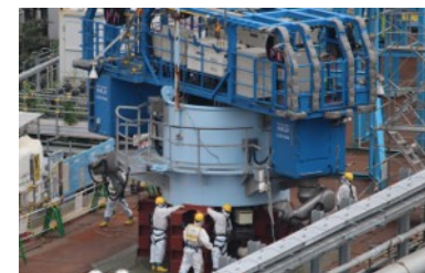
吊り降ろされた排気筒頂部
