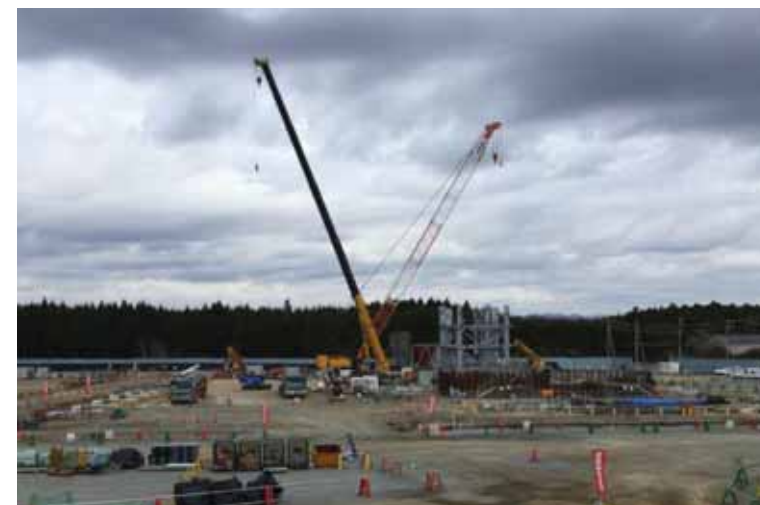
大熊町の仮設焼却施設（建設工事中）
