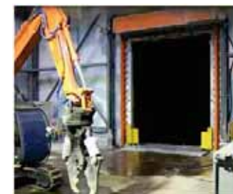
2号機オペフロ開口部設置完了 (2018年6月21日)
