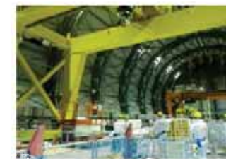
クレーンと燃料取扱機
