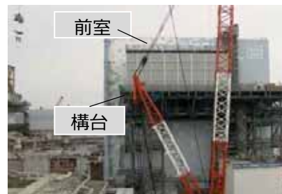
2号機原子炉建屋西側の構台と前室
