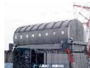
3号機原子炉建屋ドーム屋根の設置完了 (2018年2月23日)
