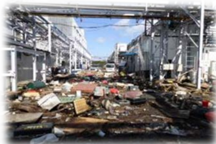
敷地内通路(流入物)
