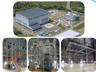
楡葉遠隔技術開発センター内の原子炉実寸大模型(モックアップ) ※3 国立研究開発法人日本原子力研究開発機構
