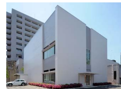
福島県立医科大学内の環境動態解析センター棟 維持管理費 約4000万円/年
