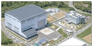
楢葉遠隔技術開発センター
