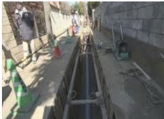
下水道管渠整備
