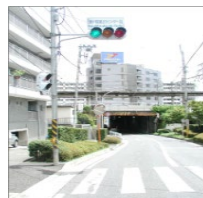
信号機の新設
