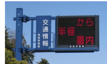
交通情報板の新設
