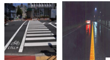
道路標示の新設
