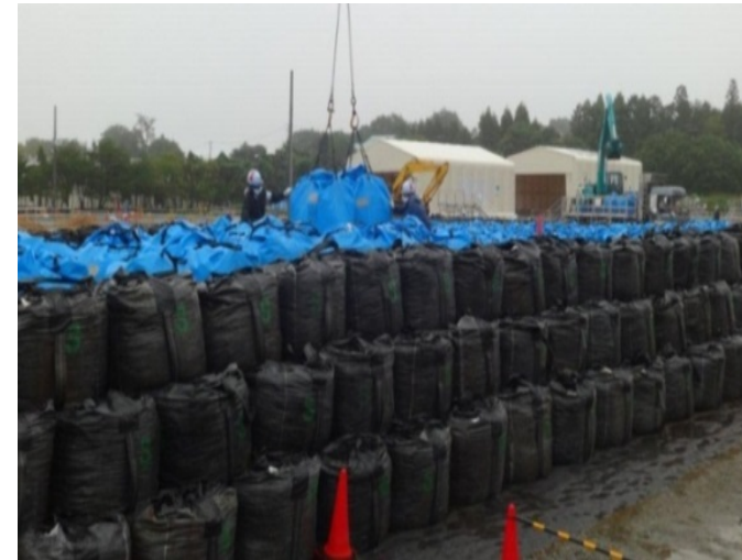
保管場への定置作業
