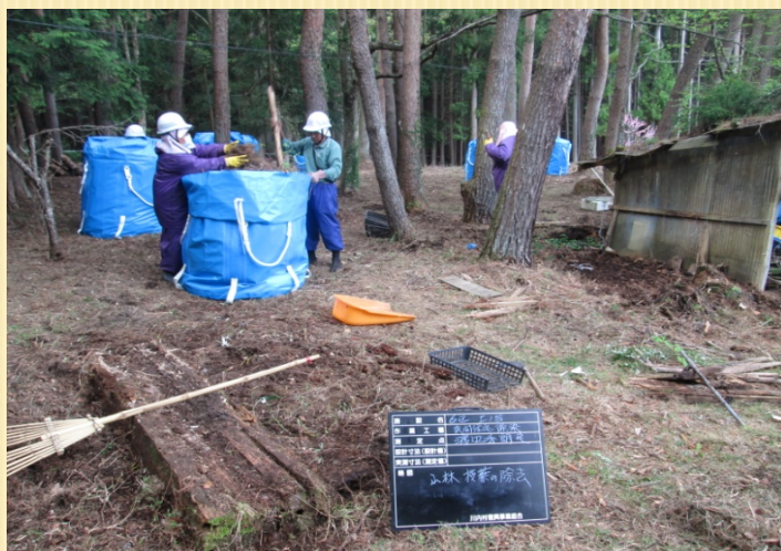
落ち葉等フレコンバック詰め込み作業
