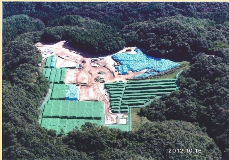
仮置き場の全景
