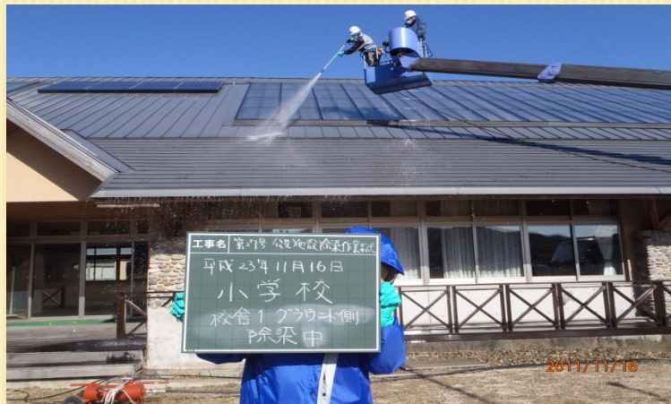
屋根の高圧洗浄機による除染
