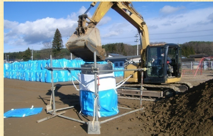
フロンバック詰め込み作業
