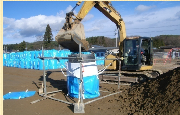
フレコンバック詰め込み作業
