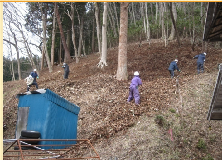
人力による落ち葉除去作業
