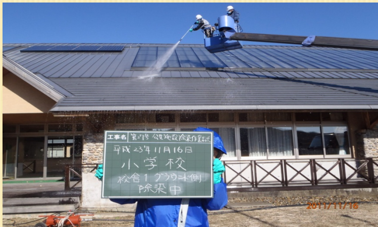
屋根の高圧洗浄機による除染
