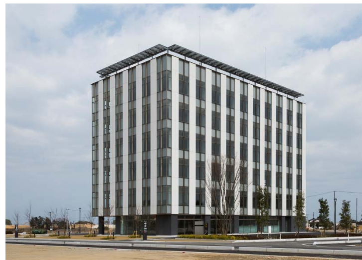
広野駅東側開発整備事業において完成したテナントビル（広野みらいオフィス）
