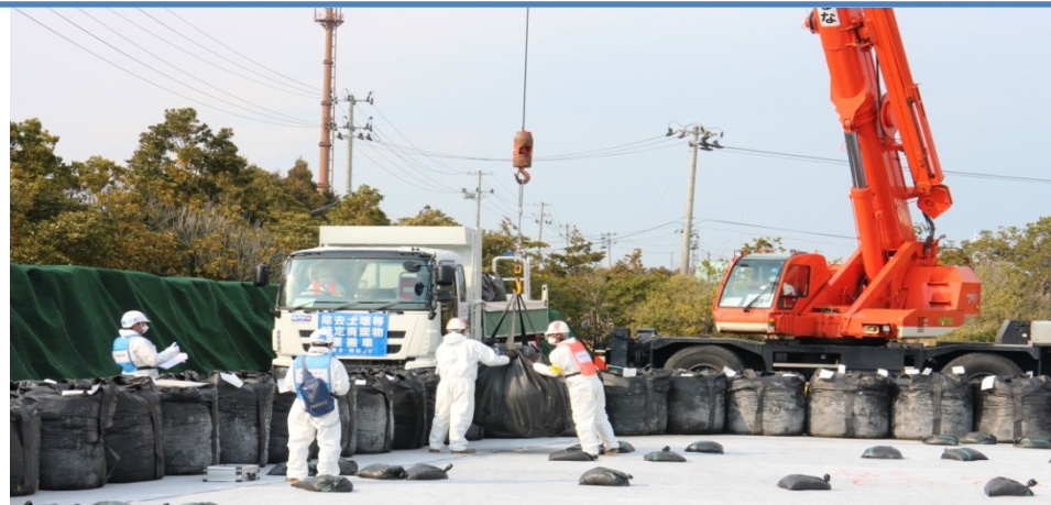
保管場への搬入・定置作業
