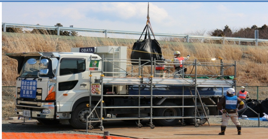
仮置場からの搬出作業
