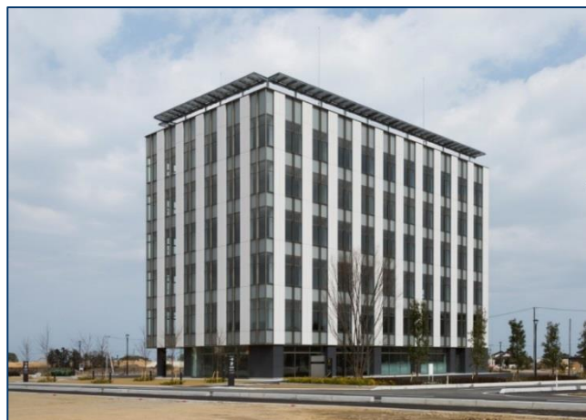
完成したテナントビル（広島みらいオフィス）
