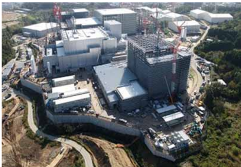
ヤード全景：2019年11月20日現在
