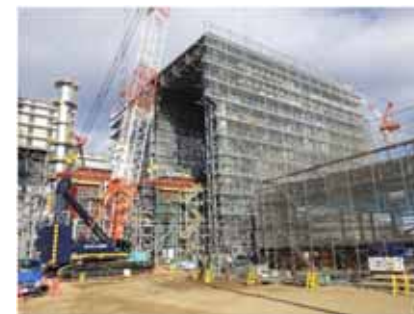
仮設灰処理施設：機器据付
