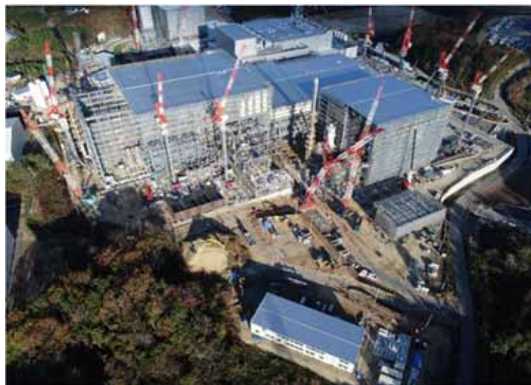
ヤード全景：2019年11月20日現在
