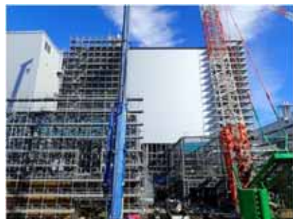
仮設焼却施設：機器据付
