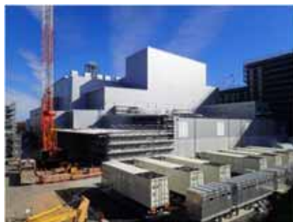
仮設灰処理施設：機器据付
