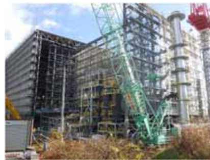
仮設焼却施設：機器据付
