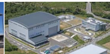
楢葉遠隔技術開発センター
