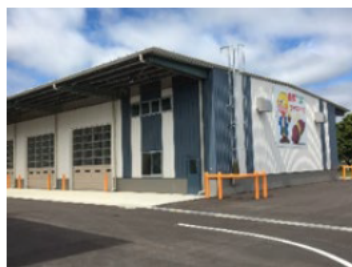
令和2年度に交付金を活用して整備したかんしょ貯蔵施設
