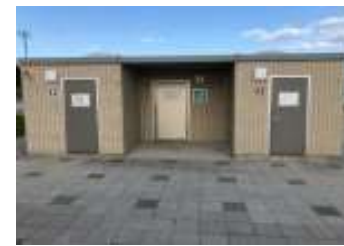
バリアフリー化の対象となる現地のトイレ棟
