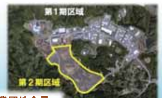
工業団地全景
