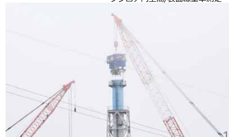
クレーン高さ確認の作業状況
