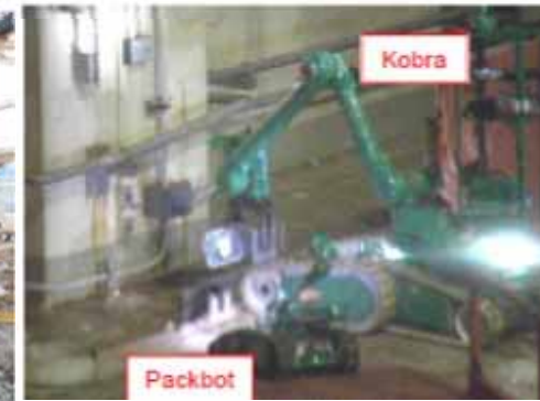
2号機ロボットによるオペレーティングフロア内空間/表面線量率測定
