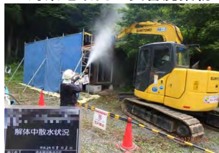
被災家屋等の解体の様子
