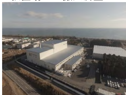
大熊町の仮設焼却施設
