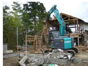
被災家屋等の解体
