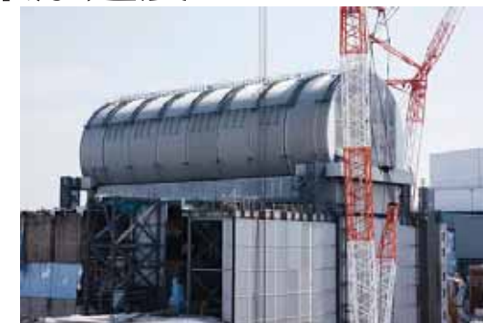
3号機原子炉建屋ドーム屋根
