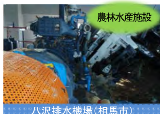
八沢排水機場（相馬市）
