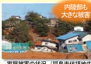
家屋被害の状況（福島市伏拝地内）
