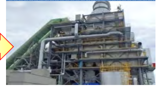
浪江町仮設焼却炉
