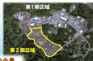
工業団地全景
