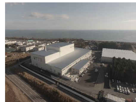
大熊町の仮設焼却施設
