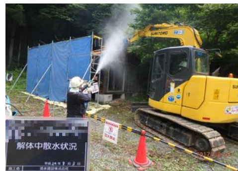
被災家屋等の解体の様子
