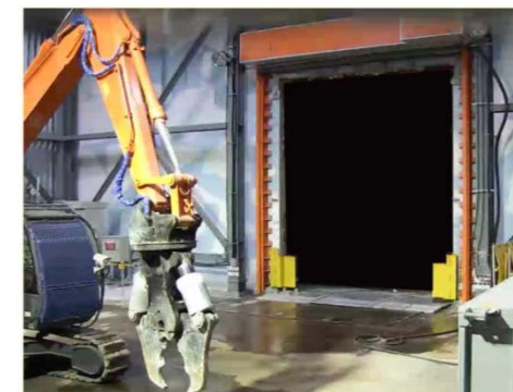
2号機オペフロ開口部設置完了 (2018年6月21日)
