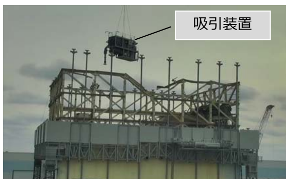
1号機建屋上部のガレキ撤去開始 (2018年1月22日)
