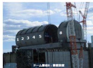
使用済み燃料 ドーム屋根の設置状況 (2017年12月19日)
