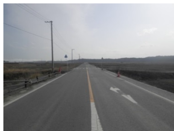
撤去後 (平成28年3月)
