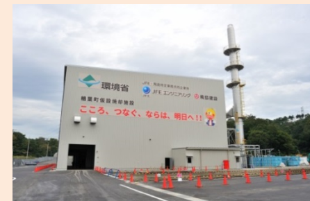
楢葉町の仮設焼却施設 (平成28年10月)
