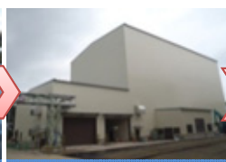
仮設焼却施設
