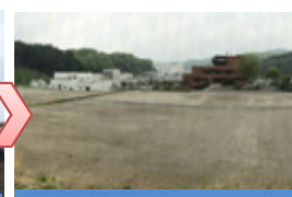
保管汚泥の状況(減容化後)
