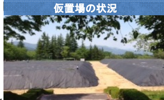
仮置場の状況
