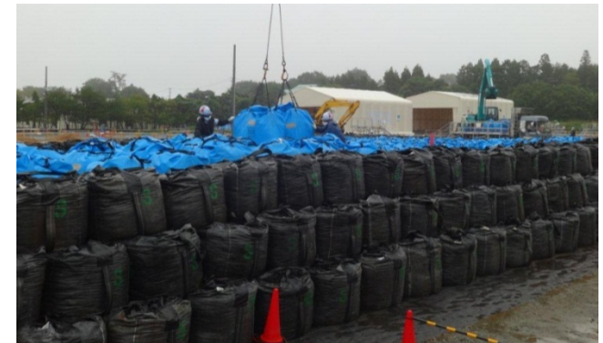
保管場への定置作業
