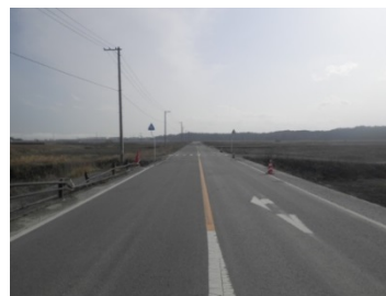
撤去後（平成28年3月）
