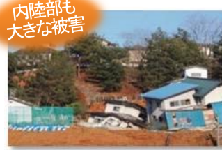
内陸部も大きな被害 家屋被害の状況（福島市伏拝地区）
