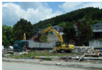
【被災家屋の解体・撤去】
