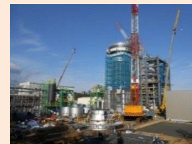
南相馬市における仮設焼却施設の建設状況 (平成26年12月)
