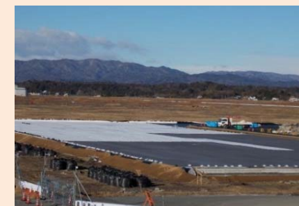
双葉町中野地区における 仮置場の整備状況 (平成26年12月)
