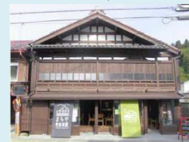
住民交流拠点施設 「まち家世田米駅」(岩手県住田町)
