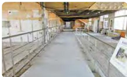
1階の見学通路。各教室は津波の直撃を受けて、壁も天井も、剥がされるように流された。傷が付き、傾いたまま、かろうじて残った備品なども震災当時のまま。津波の破壊力の凄まじさに驚かされる
