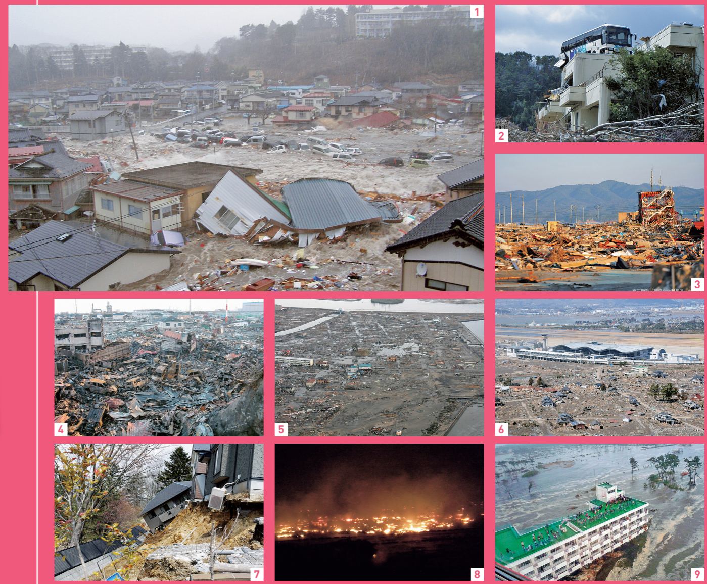
1 女川町役場周辺に押し寄せた津波 2 雄勝公民館。津波により屋根の上にバスが運ばれた 3 鉄骨のみとなった南三陸町の旧防災対策庁舎 4 石巻市門脇地区は津波と火災により壊滅状態に 5 津波に飲まれ一瞬にして町が消滅した名取市閑上地区 6 仙台空港は国内で唯一、津波による被害を受けた空港。震災当時、約1700人が取り残された 7 仙台市内の住宅地も地震被害を受けた 8 気仙沼合同庁舎から撮影した気仙沼湾の火災の様子 9 仙台市立荒浜小学校(P78)の屋上に孤立した避難者
