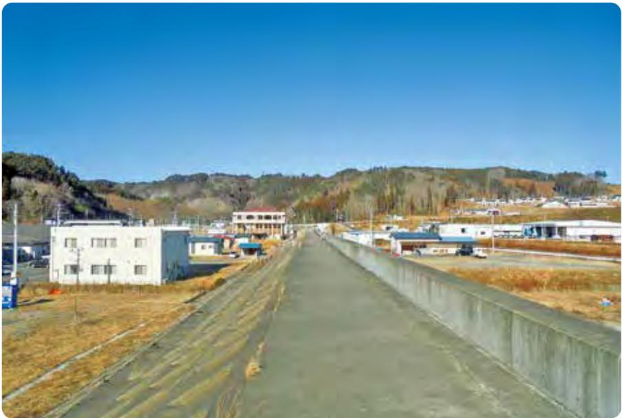
現在、壊滅を免れた第二線堤（旧第一防潮堤）は地盤沈下分をかさ上げして原形復旧され、津波の脅威を後世に伝えています。倒壊後に新たに整備された第二線堤とともに、ハード・ソフトの両面から、今後の災害時の防災が期待されています。
