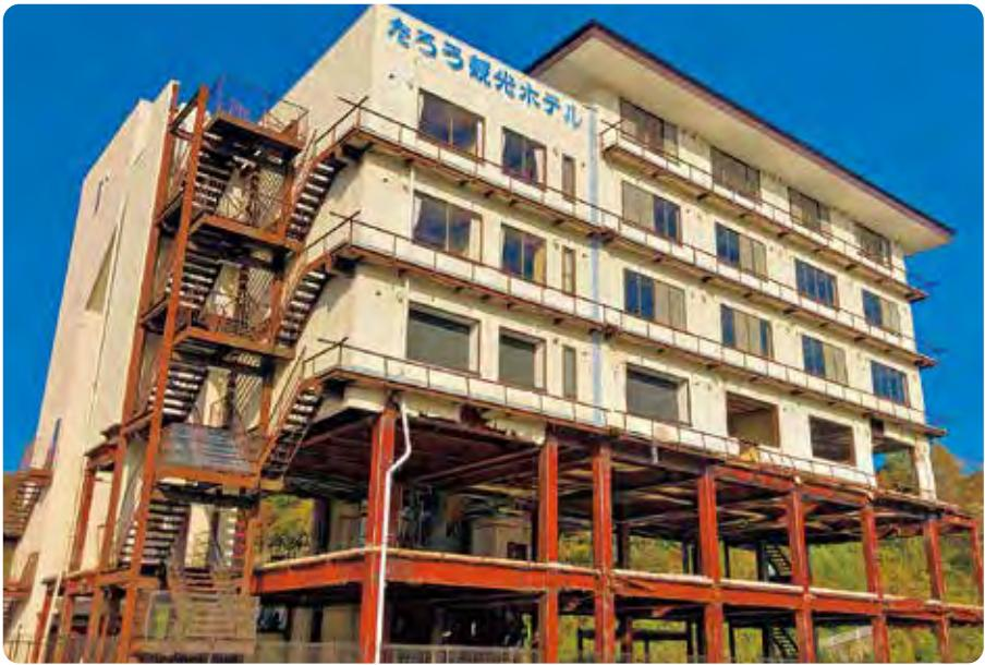
**昭和61年(1986)に建設されたたろう観光ホテルは6階建ての建物で、田老漁港の北側約400mの場所に位置しています。震災時には高さ17mを超える津波が建物を直撃し、4階まで浸水。2階までは柱だけを残してすべて流失しました。しかし倒壊することなく現在の姿で留まつたのです。**
